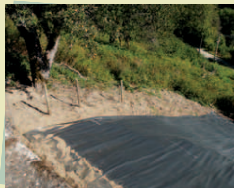
Station de renouée après travaux
