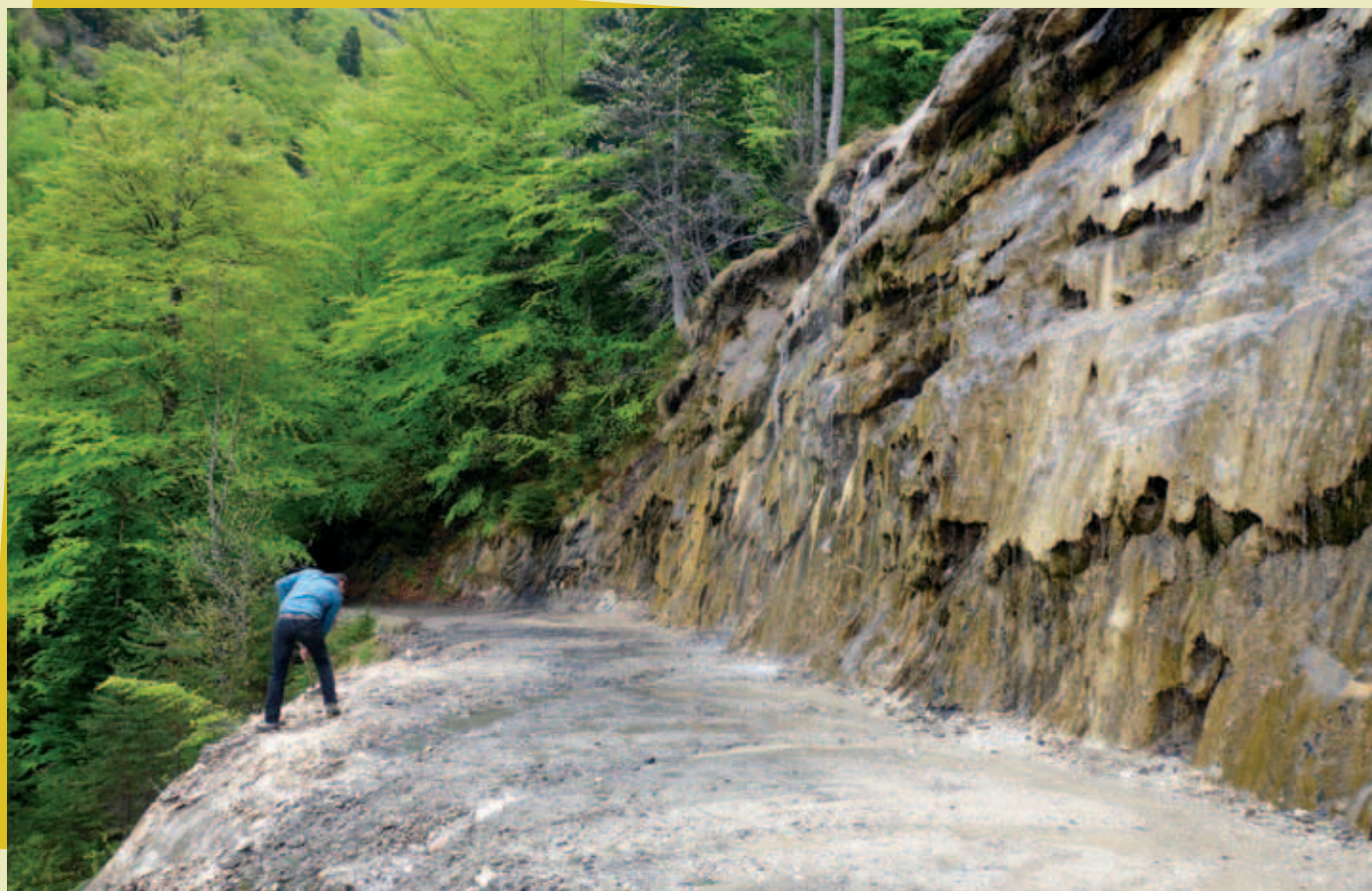
Travaux d'aménagement de la piste de la tufière d'Ornon
